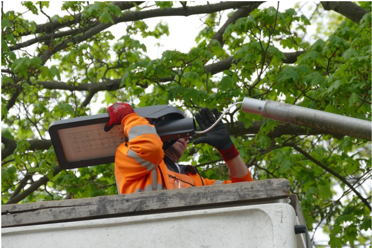
Abbildung 2: Einbau neuer LED-Lampenköpfe in die Straßenbeleuchtung Sommerfelde
